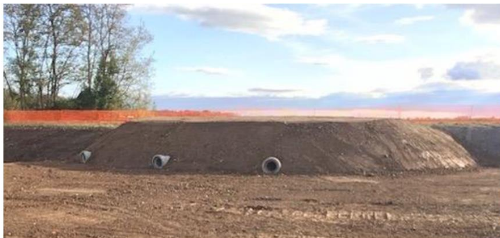
Figures 18 : Vues des travaux d'installation du terrier artificiel terminé (Source : SNCF Réseau)
