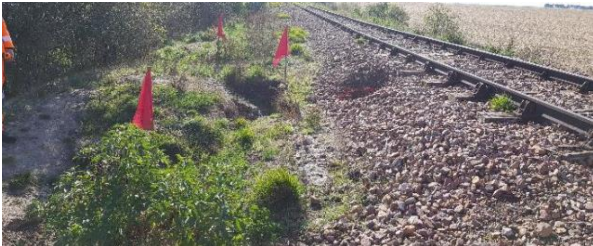
Figure 17 : Exemple récent de terriers dans un remblai près de Pithiviers (45) ayant entraîné l'arrêt de la circulation des trains (source : SNCF Réseau).
